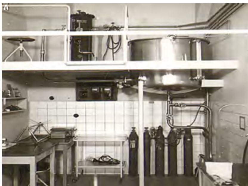
OBŘ. 3 Technická místnost umělé ledviny s kotlem pro dialyzační roztok (A). Alwallova umělá ledvina (B)
